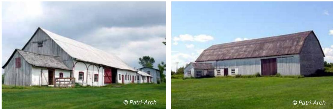
Figure 17 : Granges-étables avec toiture à deux versants (gauche) et à toit brisé (droite).
