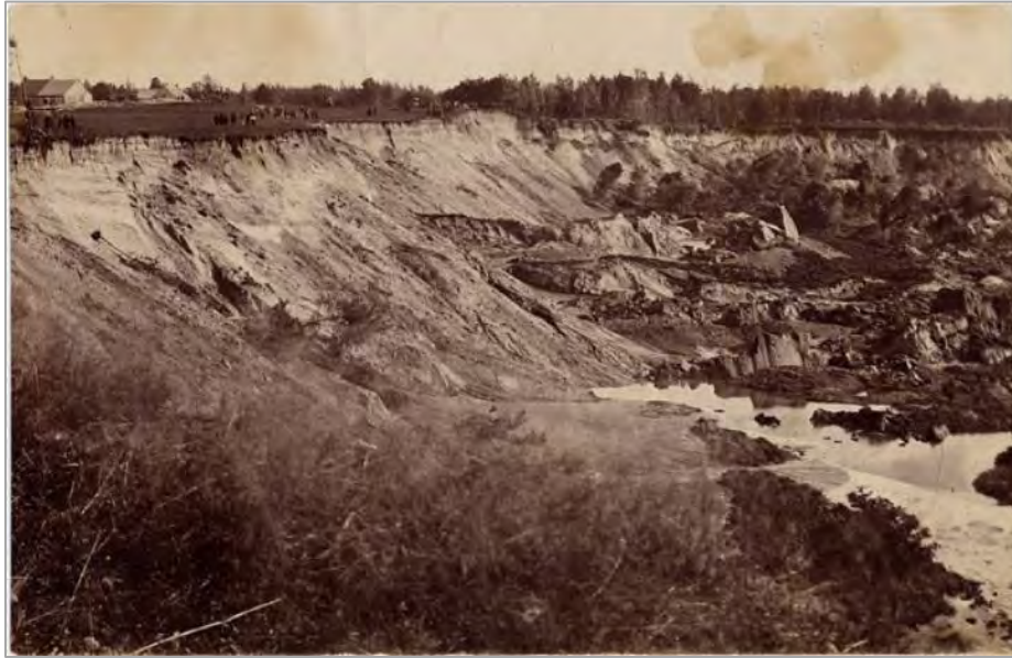
Figure 8 - Vue du glissement de terrain survenu le 27 avril 1894 à Saint-Alban 7
