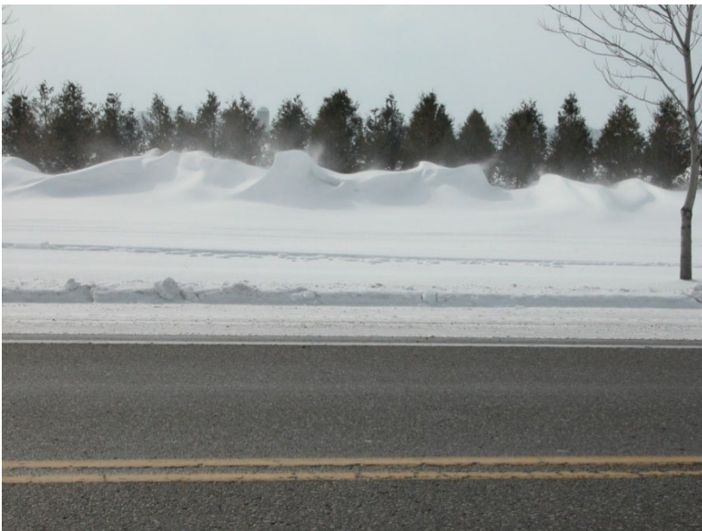
Exemple d'accumulation contrôlée de neige en bordure d'une route grâce à une haie brise-vent.
