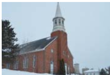
L'église deviendra une salle multifonctionnelle d'ici quelques mois. (Photo Le Quotidien, Laura Lévesque)
