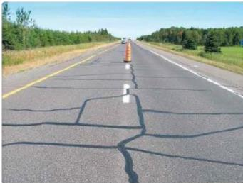
Le scellement de fissures constitue la seule intervention proposée dans la famille de l'entretien préventif. Les chaussées plus récentes (revêtement usuellement vieux de 1 à 6 ans)<sup>7</sup> et peu fissurées sont généralement candidates à ce type de recommandation.
